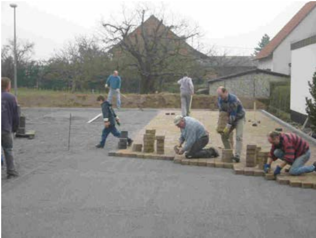
Die ersten Stellflächen sind fertig
