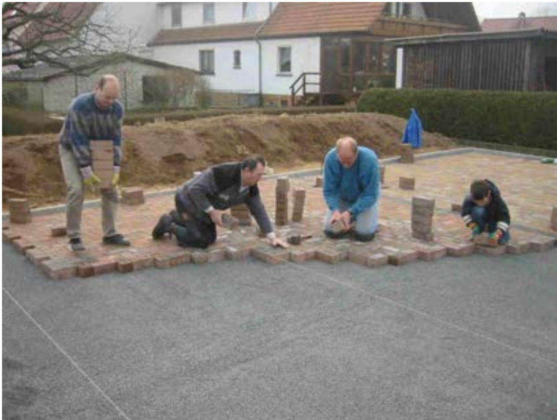
Auch beim Verlegen: Viele Helfer
