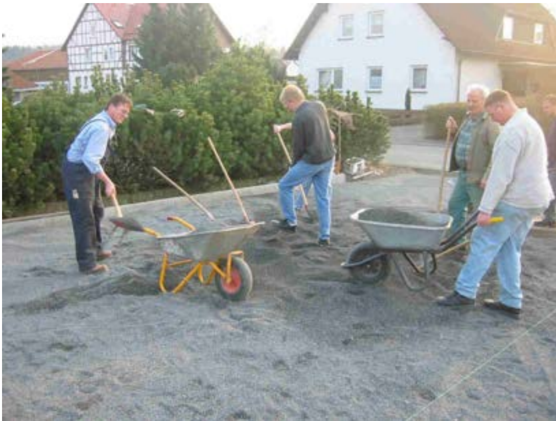
Vorarbeiten: Der Kies muss verteilt werden
