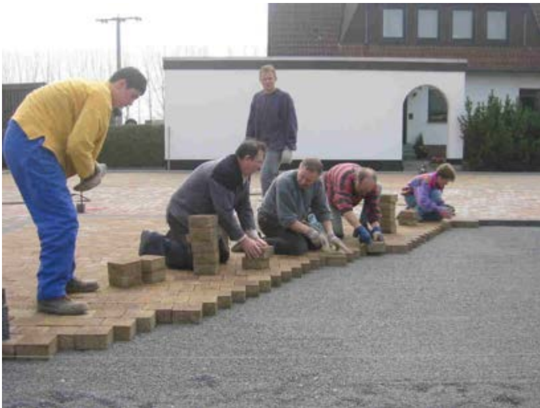
Auch beim Verlegen: Viele Helfer
