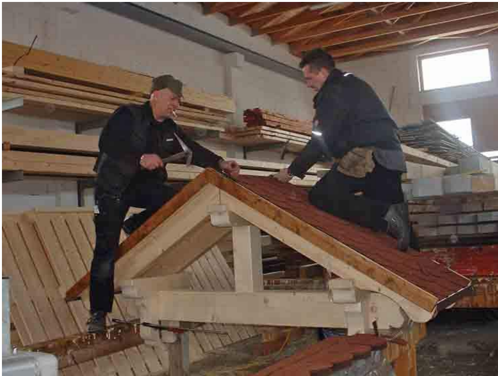
Holger Wächter (rechts) und Kollege decken das Dach
