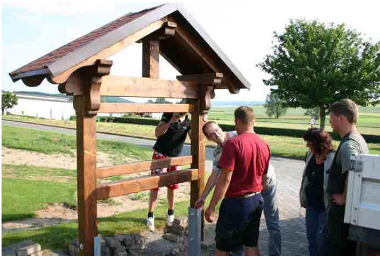
Endlich: die Konstruktion wird aufgebaut
