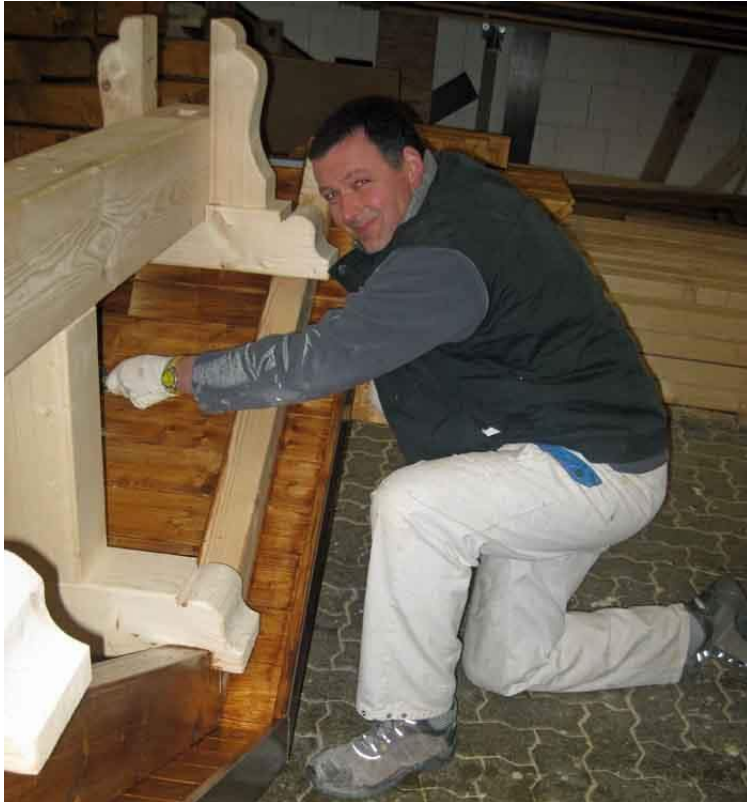
Nachdem Reiner Arend und Team die Holzkonstruktion fertig gestellt hatte, wurde in der Zimmerei gestrichen, hier Jörg Gerhold
